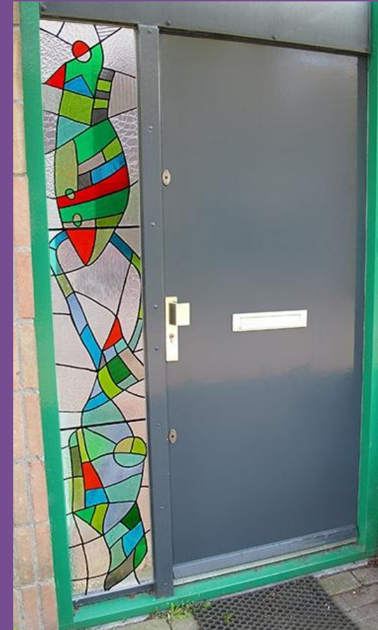
Tiffanyraam: eindresultaat in kozijn geplaatst
